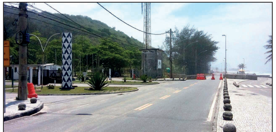
► O acesso ao camping pela praia da Barra da Tijuca está interrompido para as obras de recuperação da orla
