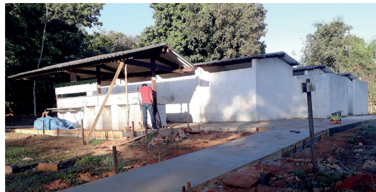
► O banheiro de Caldas Novas está todo reformado
