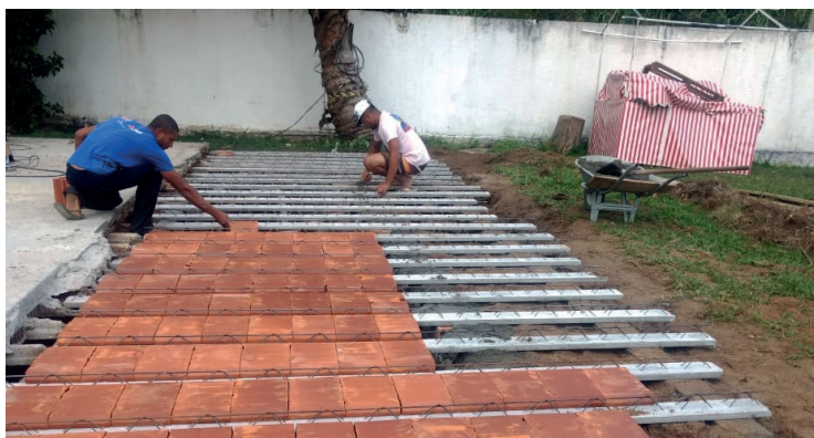
► Em Guarapari, foi recomposta a laje do tanque de efluentes
