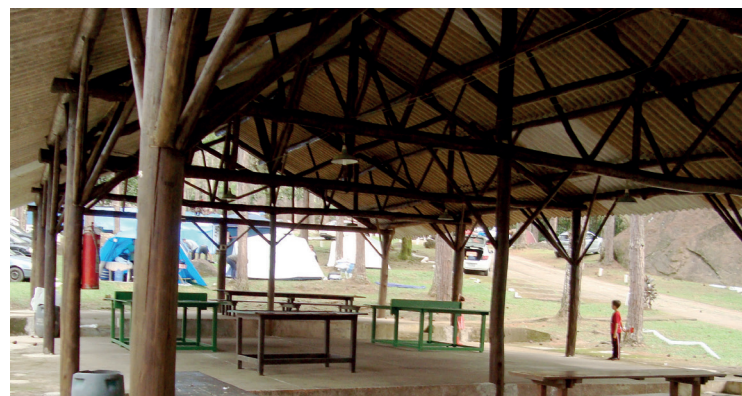
► A estrutura do pavilhão da Serrinha foi totalmente recomposta
