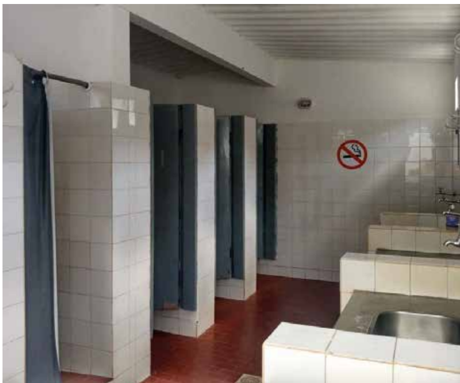
► Banheiros reformados preservam o padrão da rede e a funcionalidade
